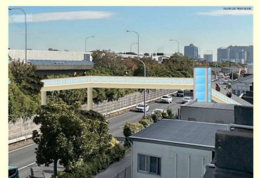
駅と公園を直結させる歩道橋は、南北一体のまちづくりに不可欠！
